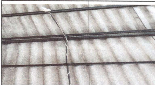
Foto8: REPARACIÓN DE CABLEADO ELÉCTRICO
