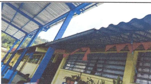
Foto 3: CANALES Y BAJADAS DE AGUA PLUVIAL
