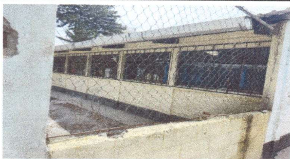
Foto7: REPARACIÓN DE TUBO HG Y MALLA GALVANIZADA
