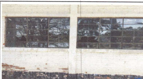
Foto 4: PINTURA EN MUROS EXTERIORES E INTERIORES
