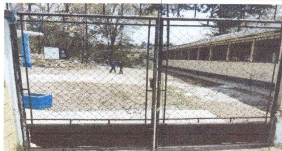
Foto 6: MANTENIMIENTO DE PORTONES
